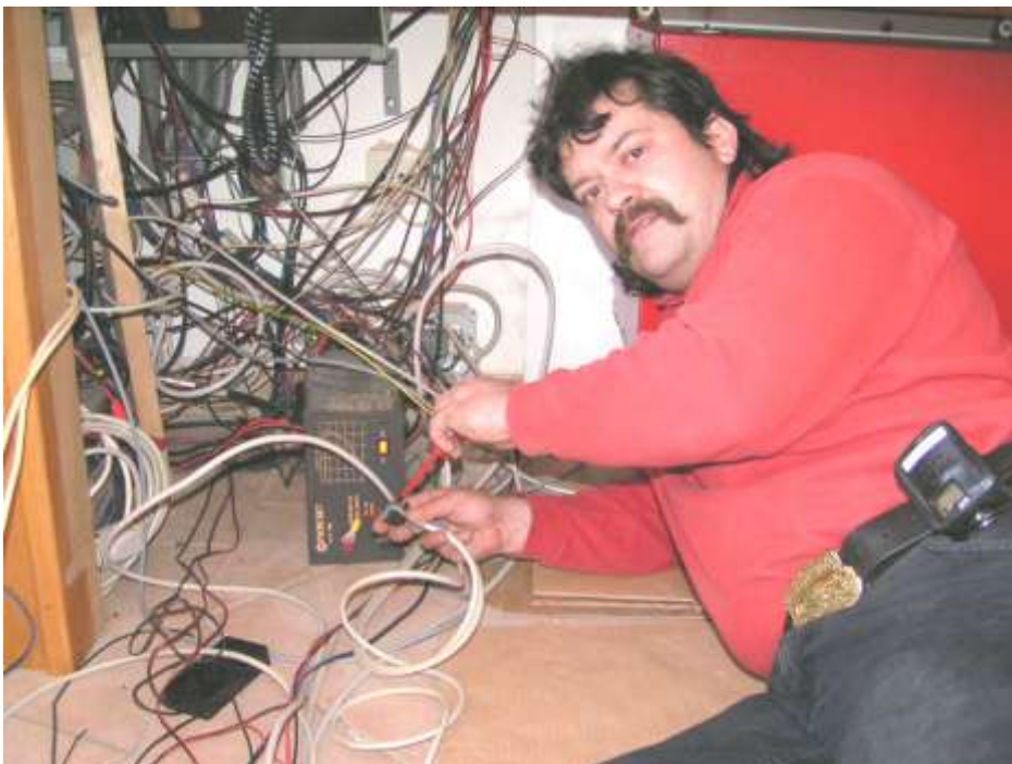
Funkbeauftragter Andreas Jenzuer: Installation WAS neu
